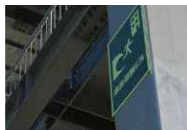
津波避難ビル 徳島県阿南市
