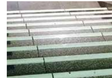
津波避難タワー 徳島県
